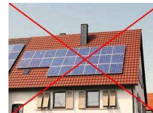
« l'installation en superposition est permise, à condition d'être parallèle au plan de la toiture et le plus proche possible de celle-ci. »
