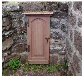
Exemples à suivre : coffrets de branchement encastrés dans le mur et dissimulés derrière une menuiserie traditionnelle bois ou métal peint.
