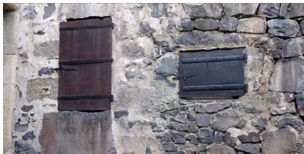
Exemples à suivre : coffrets de branchement encastrés dans le mur et dissimulés derrière une menuiserie traditionnelle bois ou métal peint.
