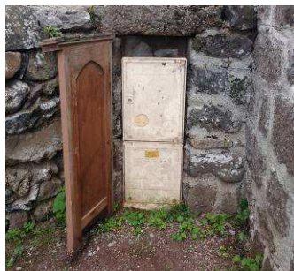
Exemples à suivre : coffrets de branchement encastrés dans le mur et dissimulés derrière une menuiserie traditionnelle bois ou métal peint.
