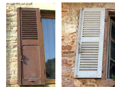
Volet semi-persienné et volet à persiennes
